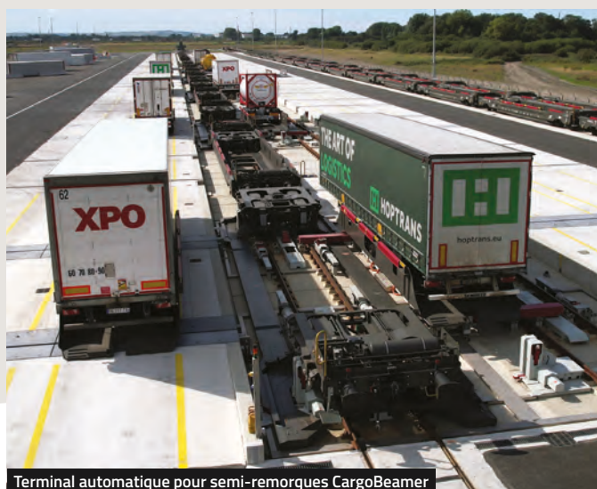
Terminal automatique pour semi-remorques CargoBeamer
